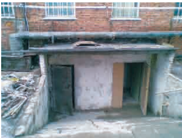
Вход в туберкулезное отделение (до ремонта)
