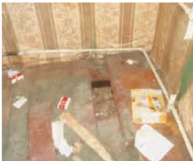
Палата (до ремонта)
