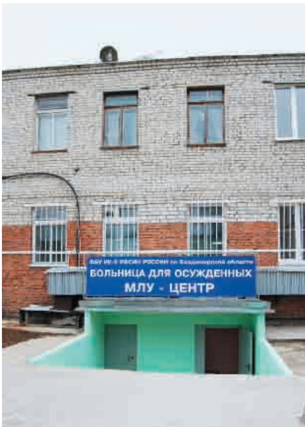
Вход в туберкулезное отделение (после ремонта)
